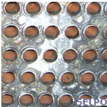
冷温水発生機 熱交換部(下部)
