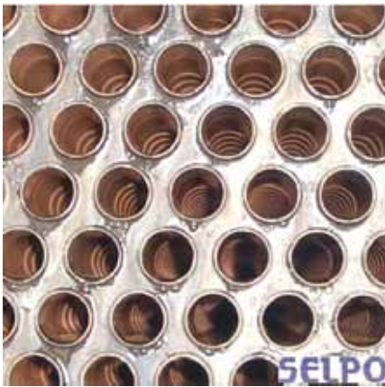
冷温水発生機 熱交換部(上部)
