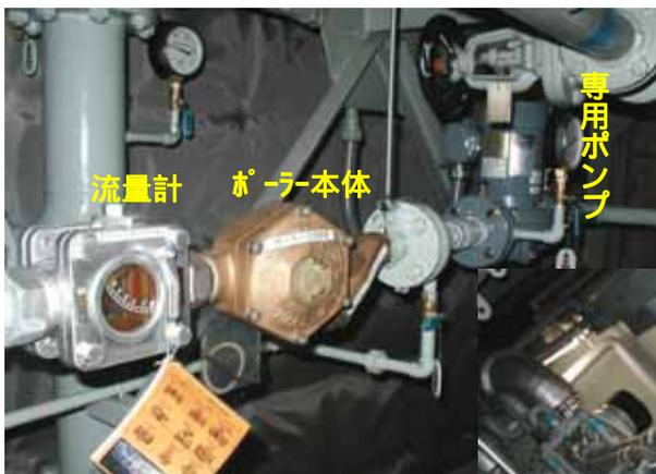
ポーラーは4 m<sup>3</sup>冷却水槽下部に専用ポンプ付き独立循環方式にてこの様に設置されました。(写真1)
