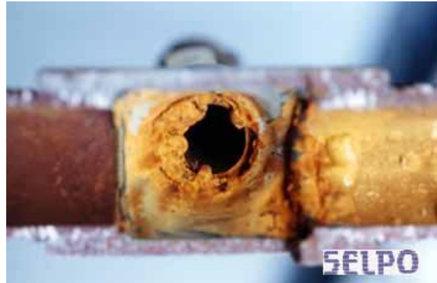
バルブとライニング管の腐食(異種金属接合)
