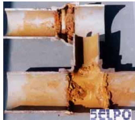
20 年経過した給水用ライニング管
