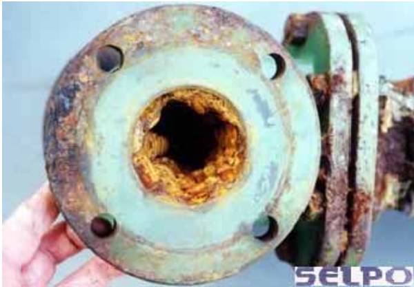
都内高層団地飲料水用フランジ内(築後 20 年)
