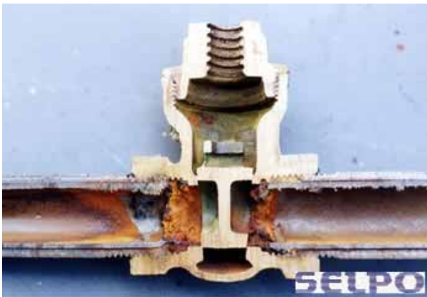
バルブとライニング管の腐食部切断(異種金属接合)
