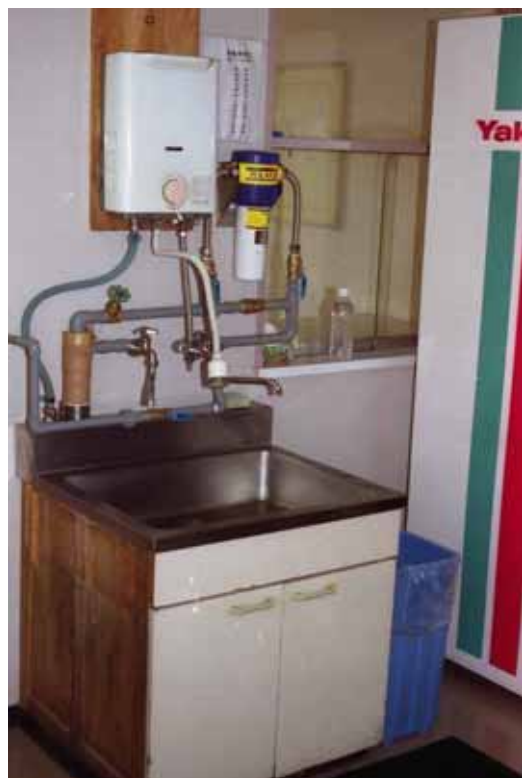
5階の給湯室にポーラー磁気活水器 PDF-1 を設置
