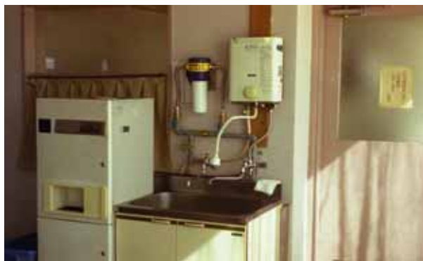
5階の食堂にポーラー磁気活水器 PDF-1 を設置
