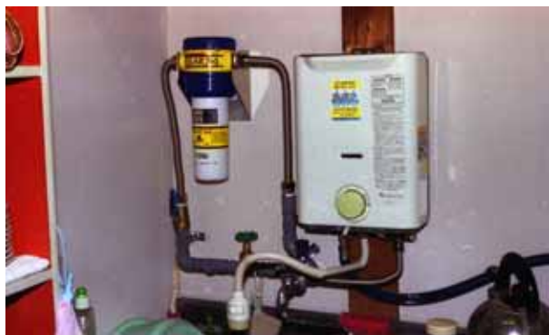
1階の給湯室にポーラー磁気活水器 PDF-1 を設置
