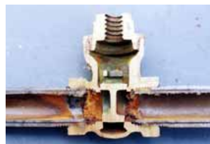
築後20年の塩ビライニング配管内部
