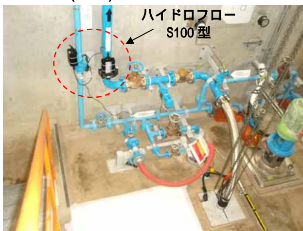
設置写真(全体)
