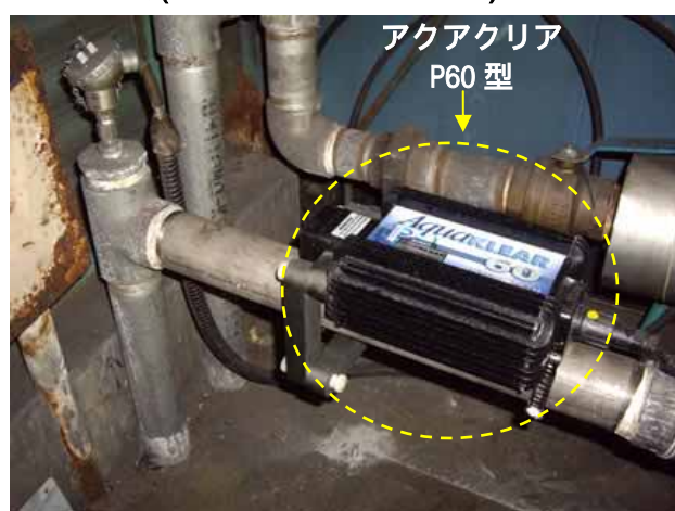
設置写真(本体は配管上に設置)
