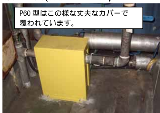
設置写真(保護カバー付)
