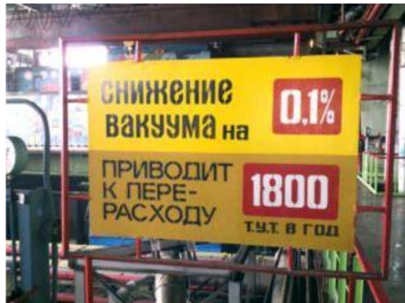
火力発電所のタービンワークショップのプラカード “0.1%の真空度のロスは1800t以上の石炭の無駄”
