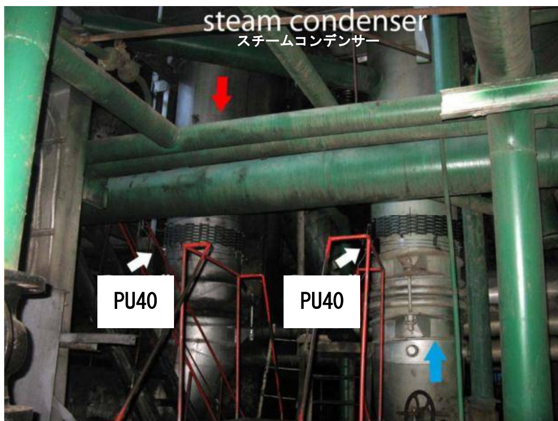
型式 PU40(1000A) を行きと帰りの双方の管上に 2 台設置した。
